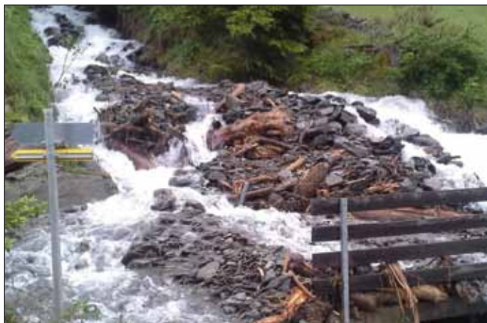
Brücke Forstweg Ronachbach (Fotos: Elmar Haid)
