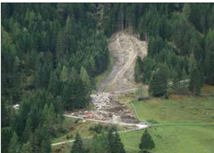
Erhöhung des bestehenden Lawinenleitdammes in Erdbauweise
