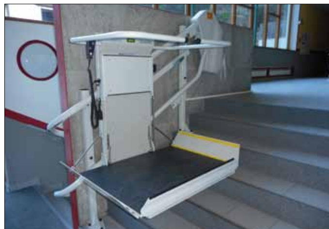
Treppenlift im Gemeindesaal St. Leonhard (Foto: Christian Melmer)
