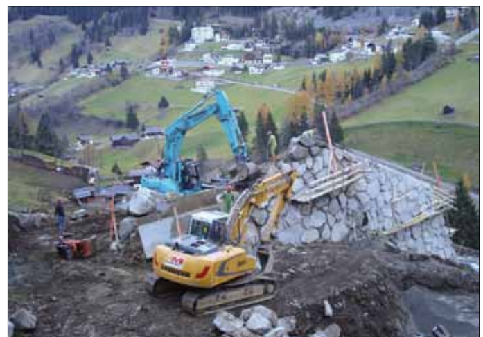
Errichtung der Lawinenablenkmauer mit Grobsteinen in Beton
