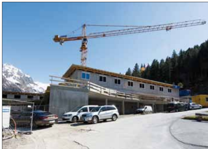
Stand der Bauarbeiten vom April 2015 (Fotos: NHT)
