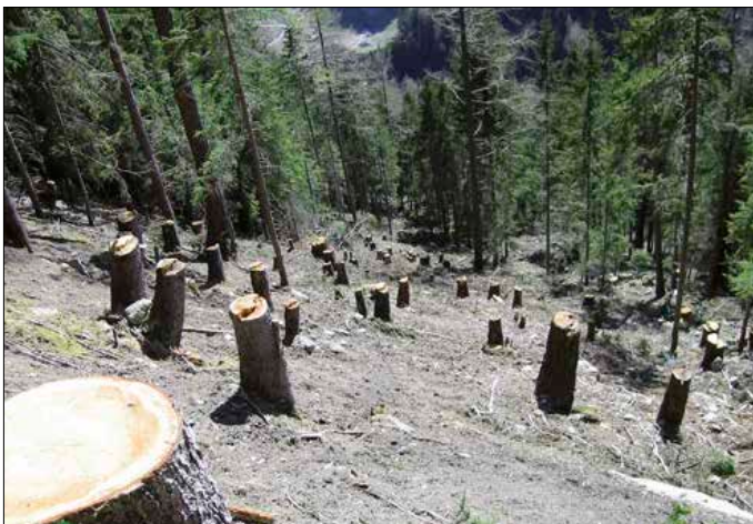
Hochabstockung (ca. 1 m) in sehr steilem Gelände am Lehen zum Schutz vor Lawinen und Steinschlag (Fotos: privat)
