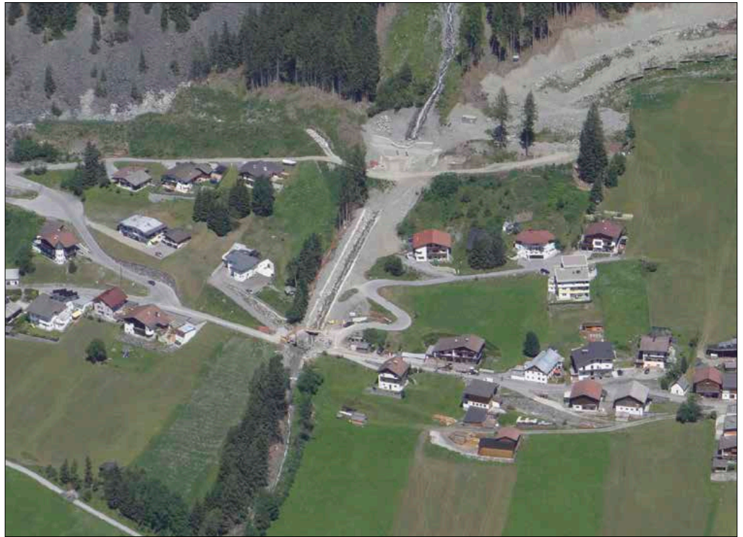
Baufeld Mitterbach während der Ausführung (Foto: WLW)
