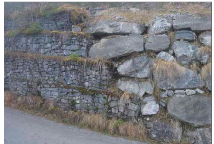
Beim Umbau des Söllbergweges wurde auf die Erhaltung der händisch gefertigten Drahtkörbe aus den 70er Jahren geachtet.
