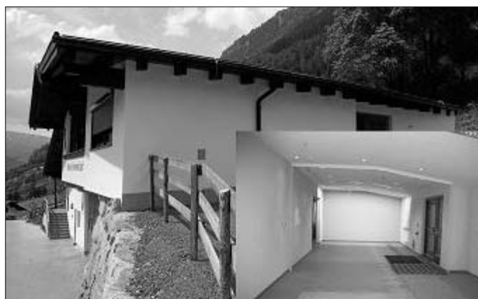
Feuerwehr- und Vereinshaus Zaunhof (Außen- und Innenansicht)
