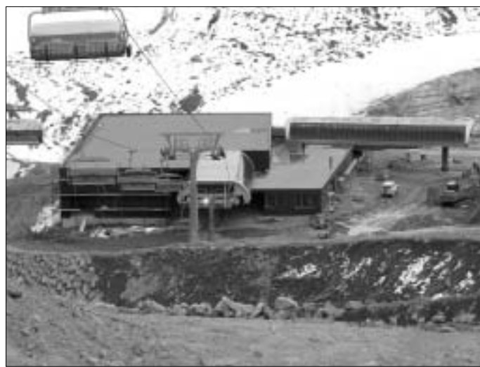
Probefahrten und Bremsproben der Sesselbahn Gletschersee mit Blick auf die gemeinsame Talstation auf 2.685 m.
