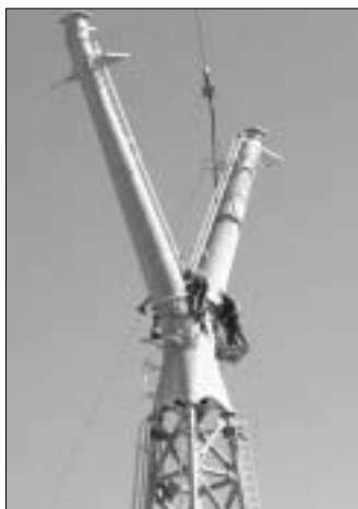
Die Montage der 60 m hohen Stütze mit Hubschrauberhilfe (Mittelbergbahn).
